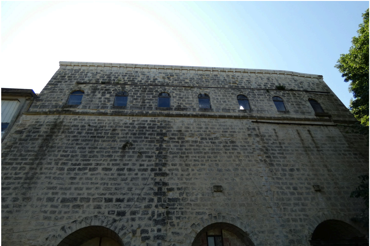
Le bâtiment des fours, élévation nord-ouest.
