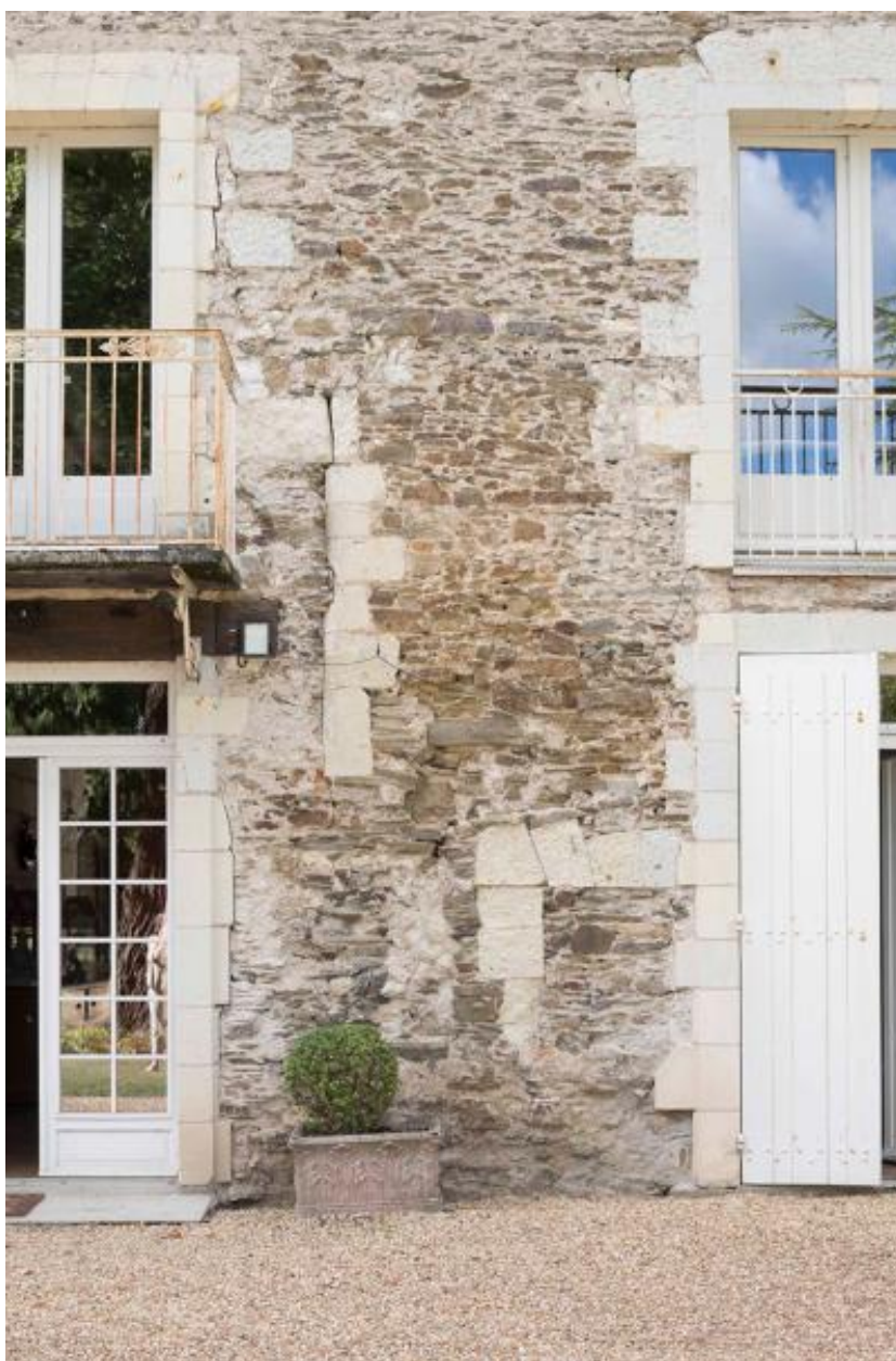
Façade est. Détail des baies obstruées.
