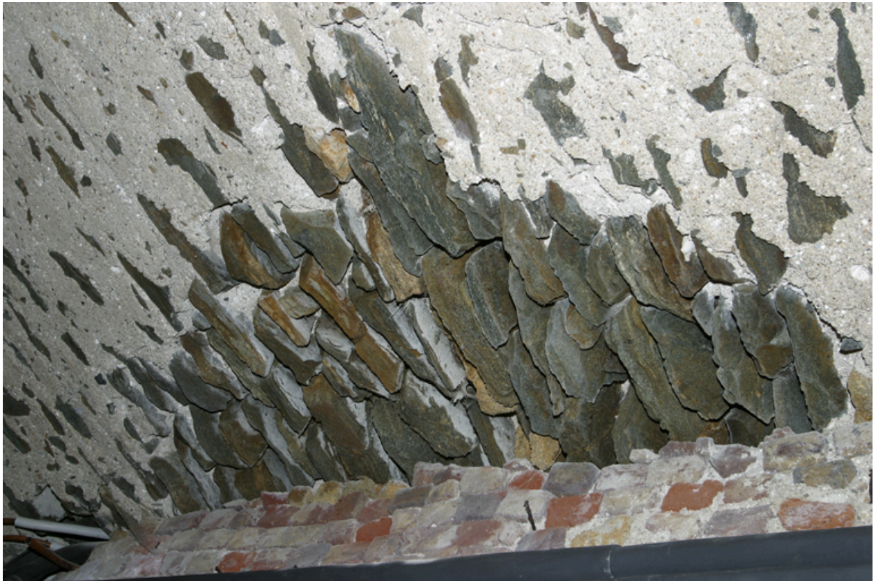
La cave située à l'ouest, détail de maçonnerie.
