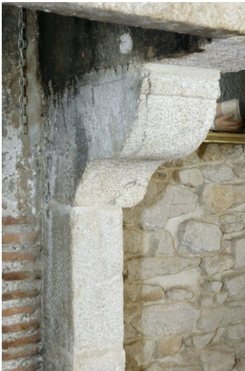
Cheminée nord au premier étage, détail de jambage.
