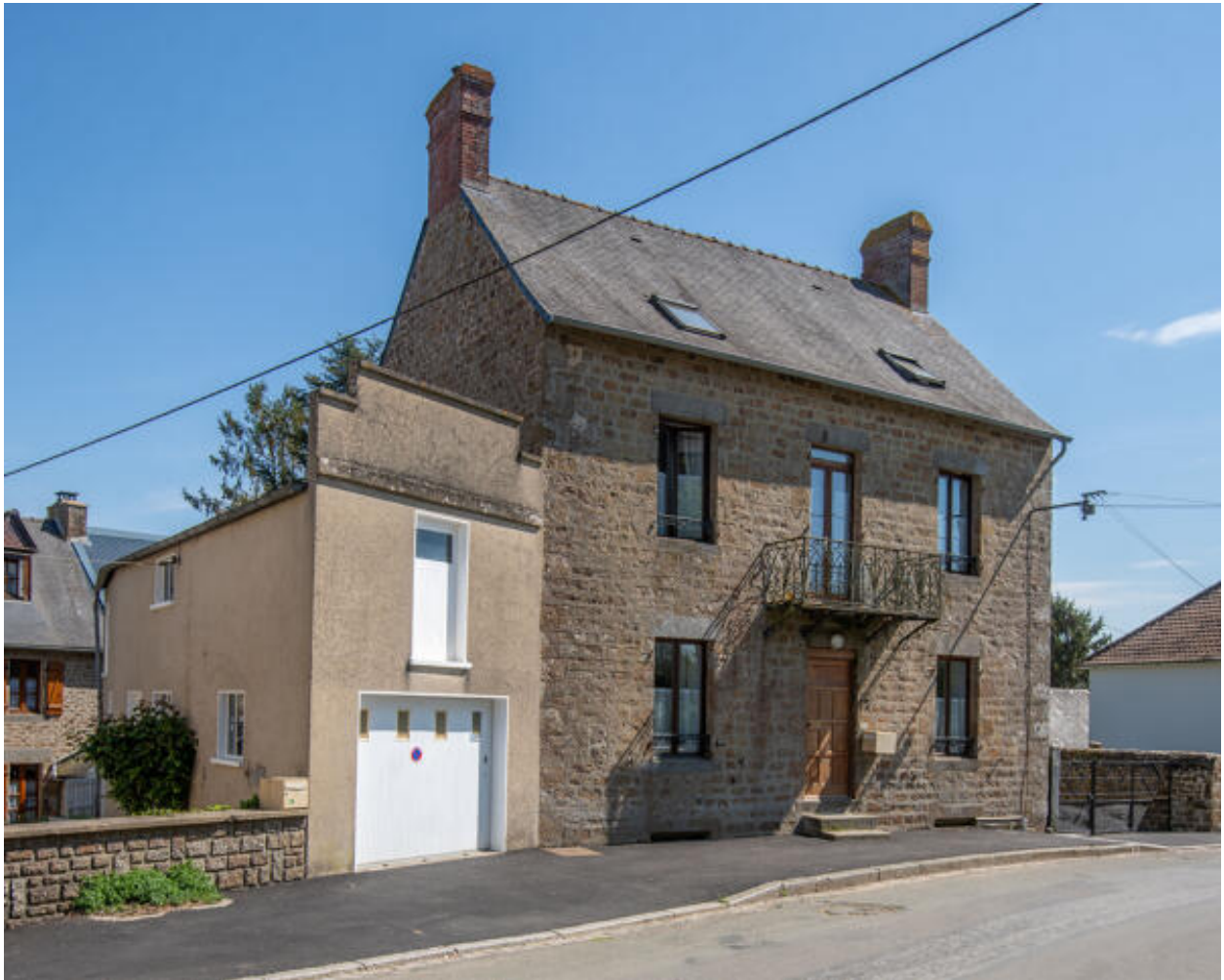
Maison et garage, 21 rue des Marronniers (2023 166 B 1126).
