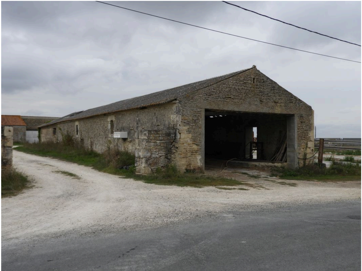
La grange à façade en pignon, perpendiculaire à la voie, vue depuis le sud-est.
