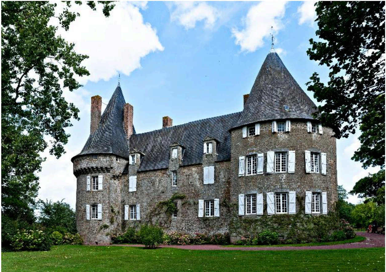
L'élévation postérieure du château vue depuis l'ouest.
