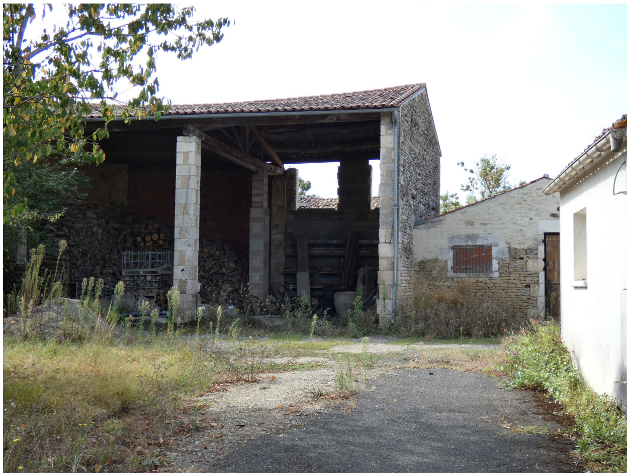
Le hangar à piliers en pierre, vu depuis le nord.
