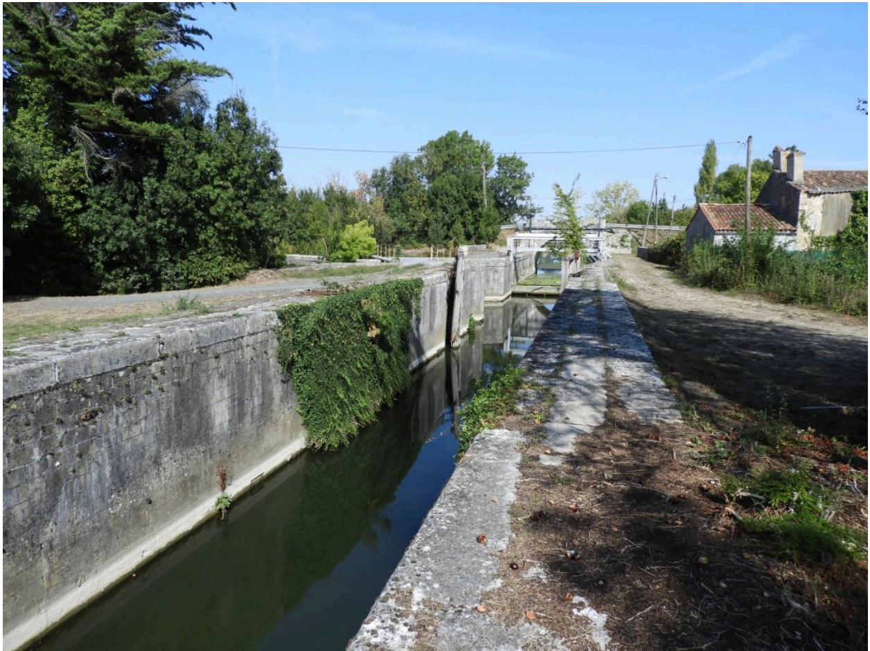
Le sas de l'écluse, vu depuis la rive gauche de celle-ci, au sud-est.
