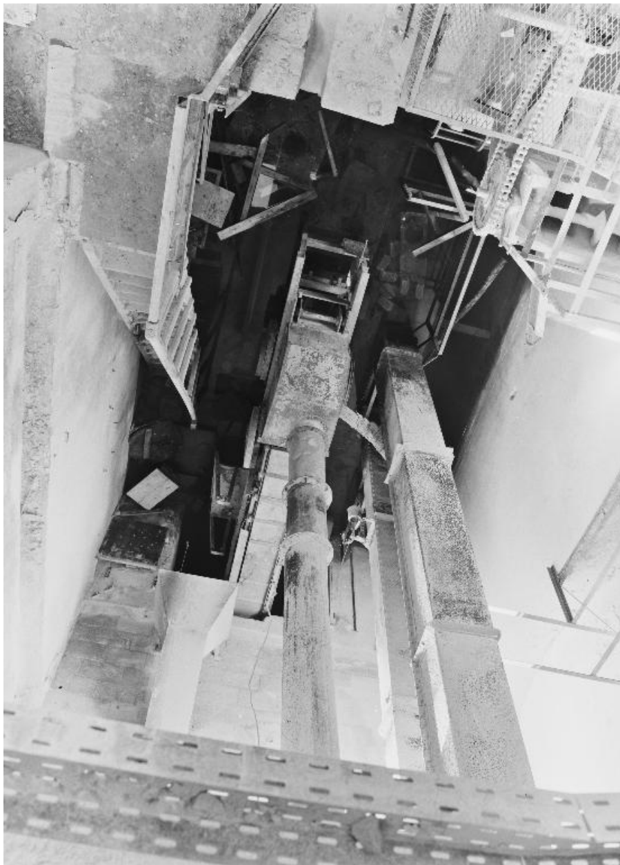
Usine de chaux : atelier de blutage ; circulation de la chaux des fosses vers les silos
