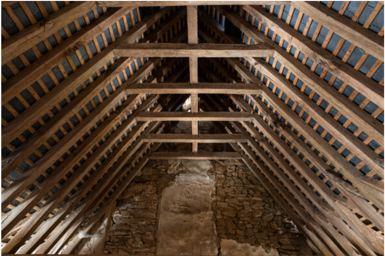
La charpente du bâtiment en abside.
