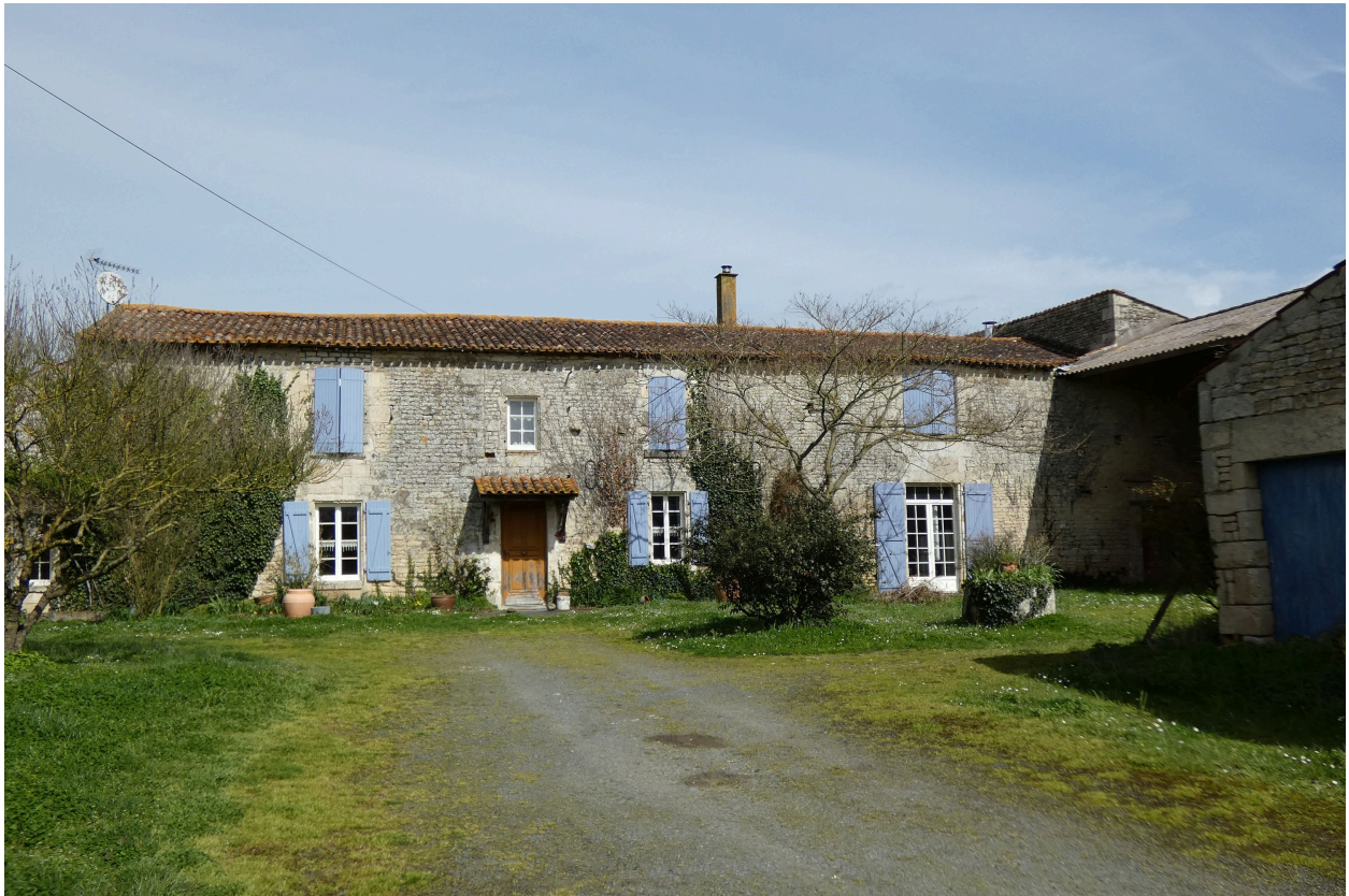
Le logis vu depuis le sud-ouest.
