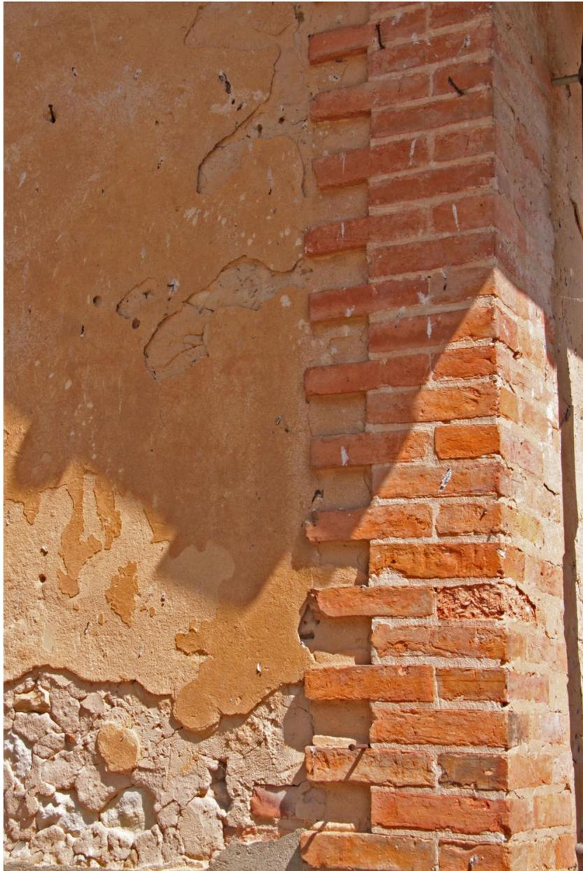
Chaînage d'angle en briques.
