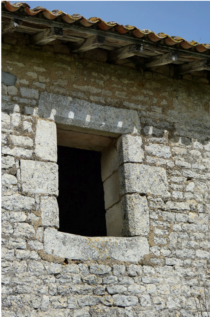
Baie à encadrement chanfreiné sur le mur sud du hangar au sud de la cour.
