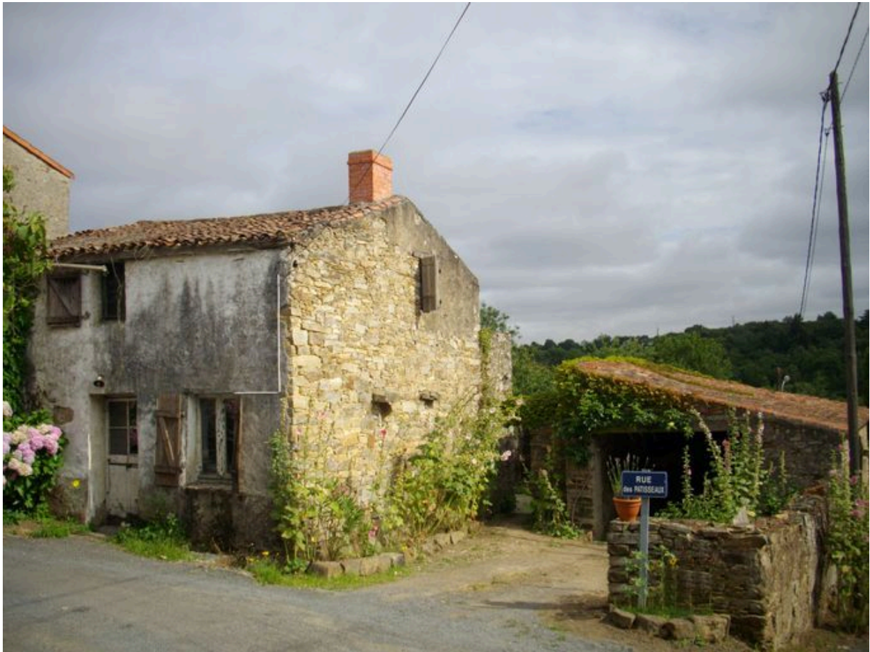
Mur pignon traversé par les corbeaux de pierre de la cheminée, 18e siècle. (La Pétière).
