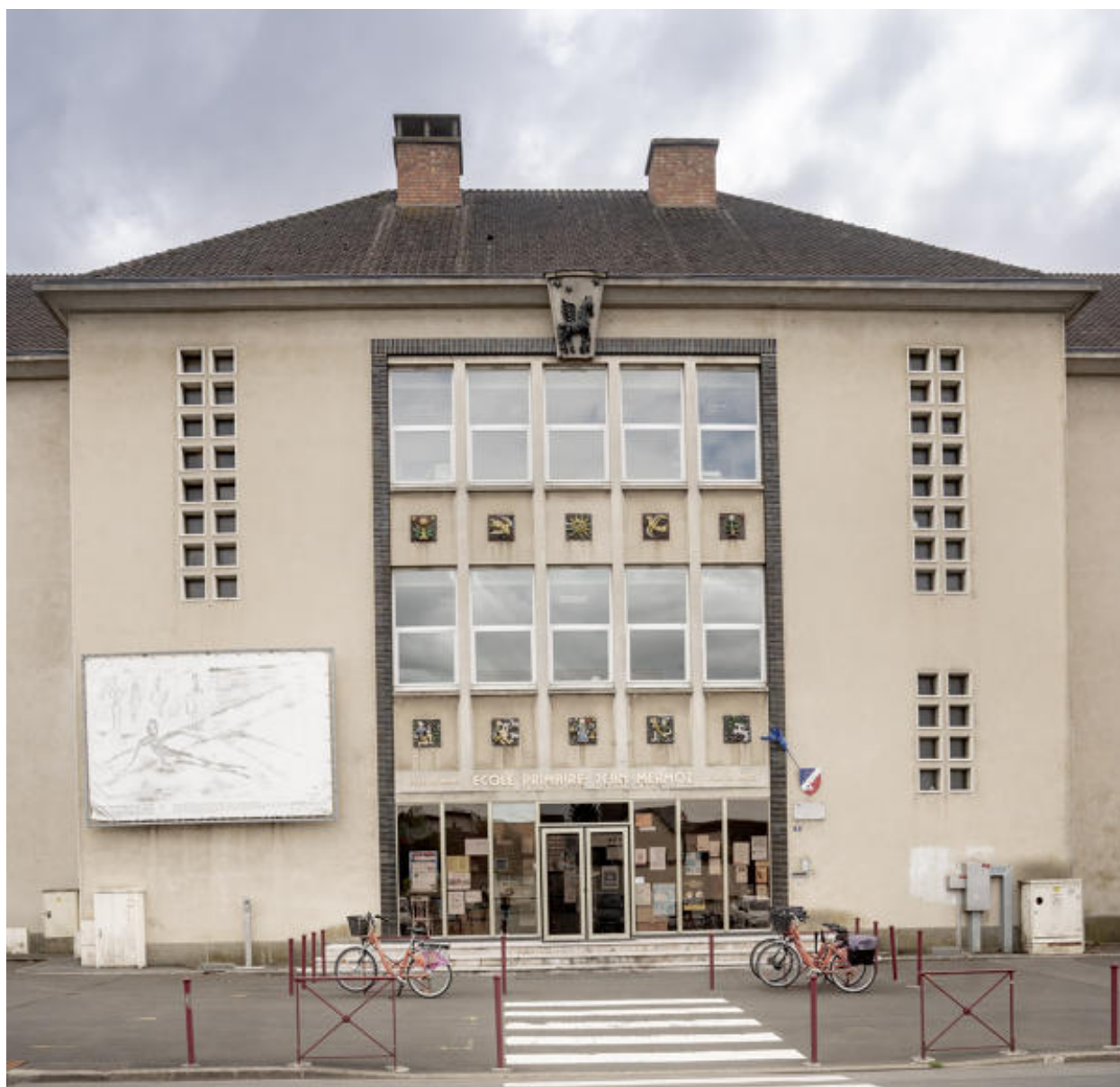
Vue de la travée centrale.
