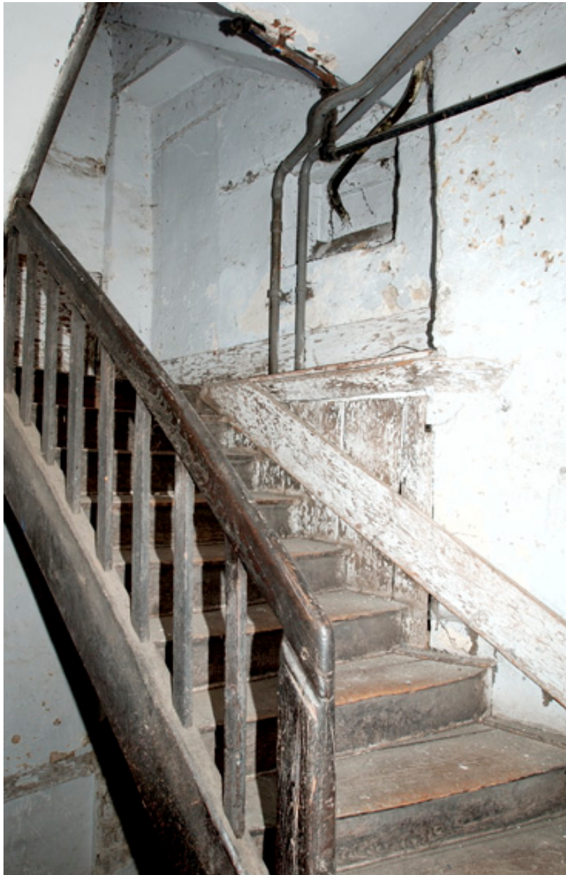
Escalier ouest en bois qui dessert les étages de la filature.
