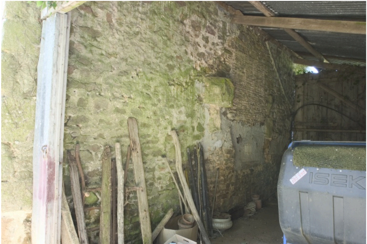
Le pignon nord-ouest de l'étable à chevaux-fournil : pierres saillantes de la cheminée du fournil.
