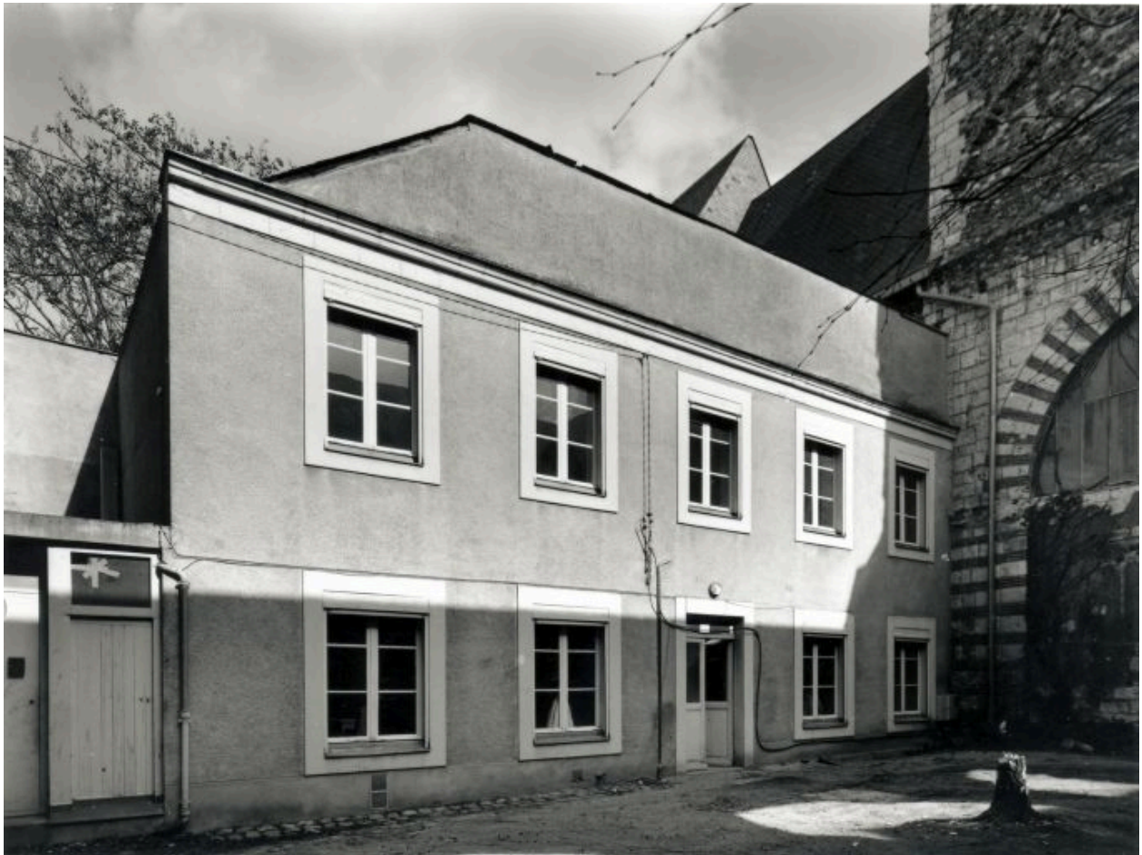
Bâtiment à l'emplacement du mur latéral sud de la nef.
