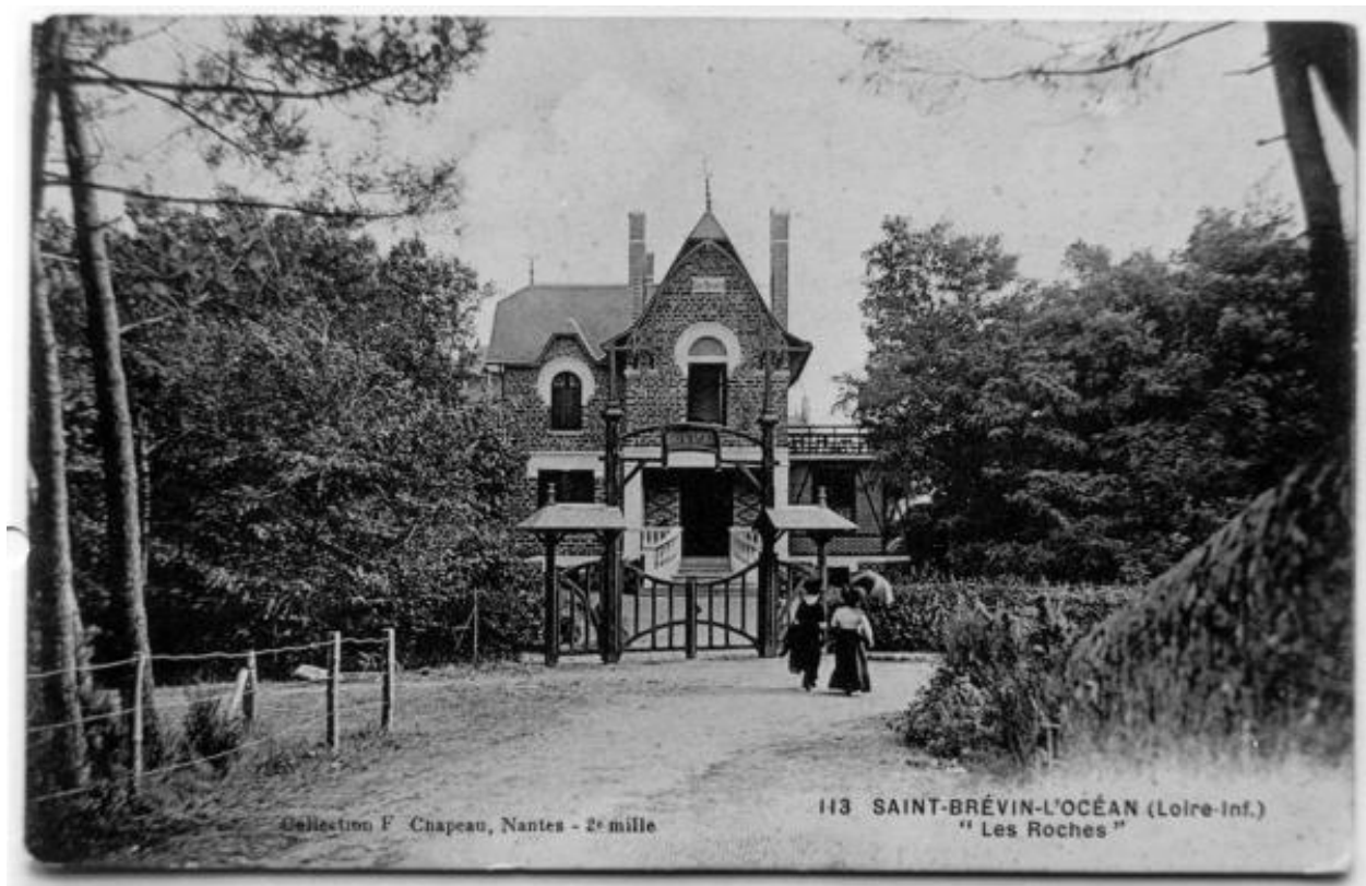
Villa les Roches. Elévation antérieure, début 20e siècle.
