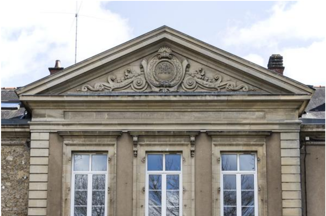
Vue du tympan sculpté en façade principale.
