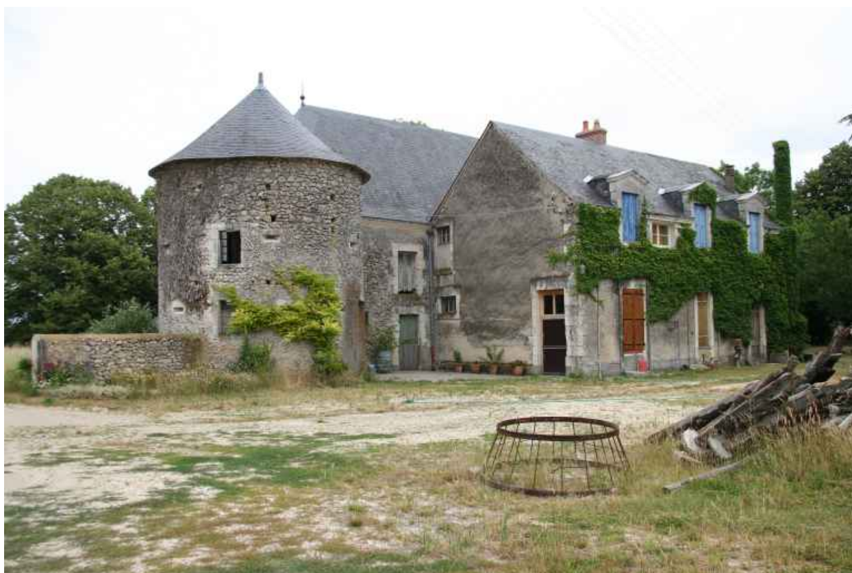
Aile ancienne, façade postérieure : bâtiment adossé.
