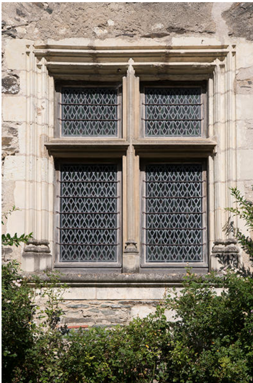
Détail de la croisée du rez-de-chaussée du logement du prêtre.
