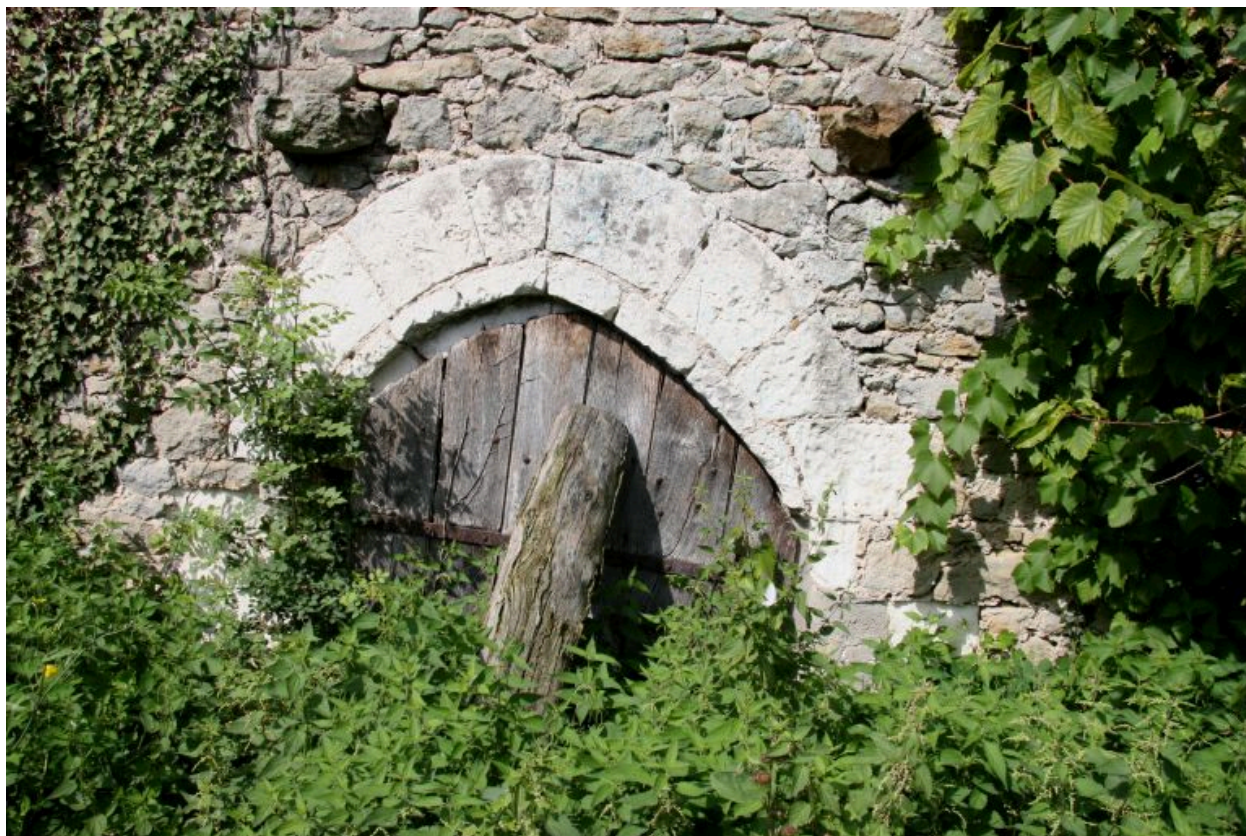
Pignon sud : porte de la cave.
