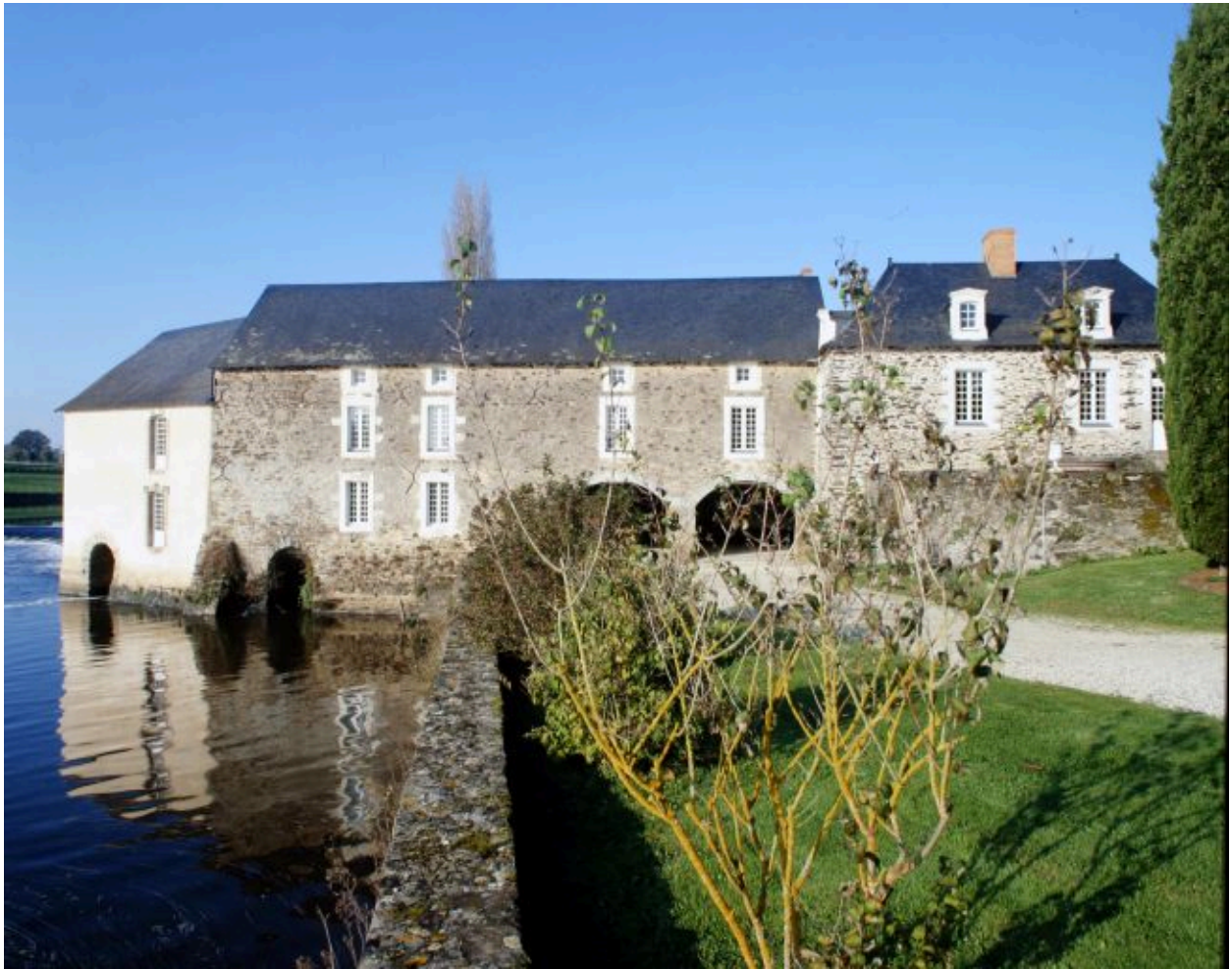
Façade sud du moulin et du logement de meunier.
