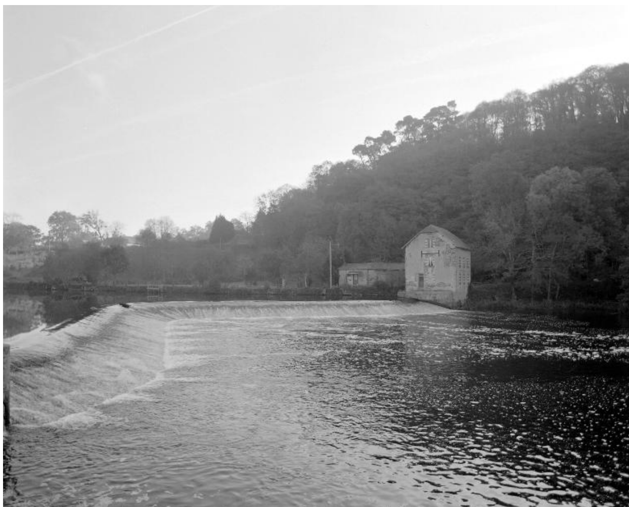
Vue depuis la rive droite : façade nord-ouest.
