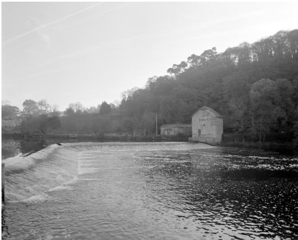
Vue depuis la rive droite : façade nord-ouest.
