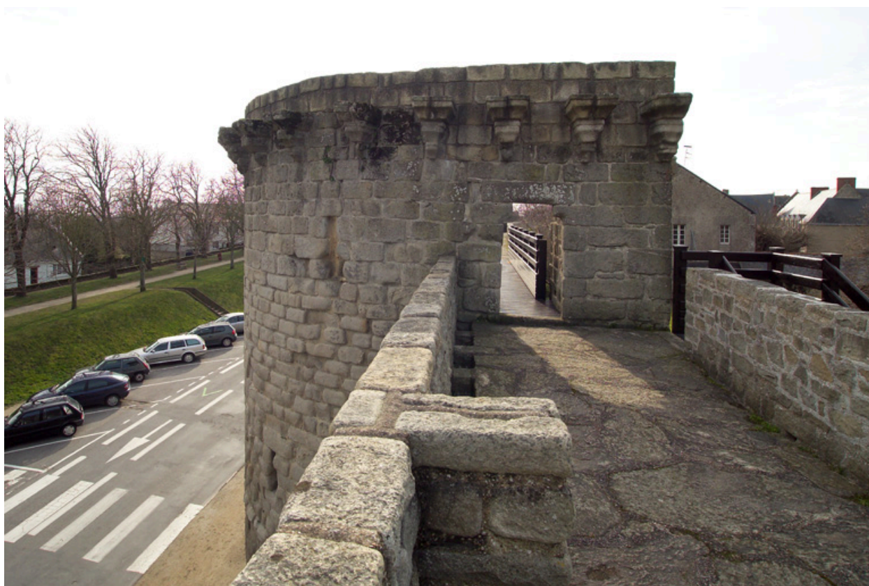
Vue de la tour depuis le chemin de ronde, vers l'Ouest.
