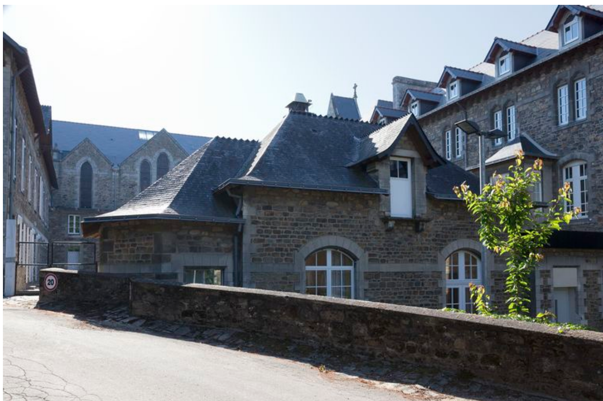
3 : à gauche, façade nord du bâtiment de la Communauté.
