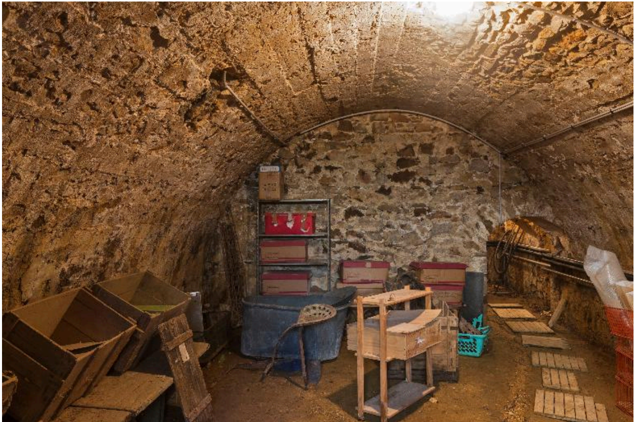
Partie droite des caves du logis.
