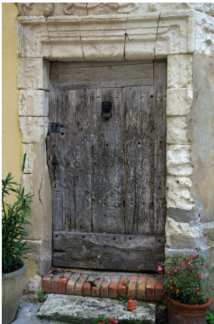
Tourelle d'escalier : menuiserie de la porte d'entrée.
