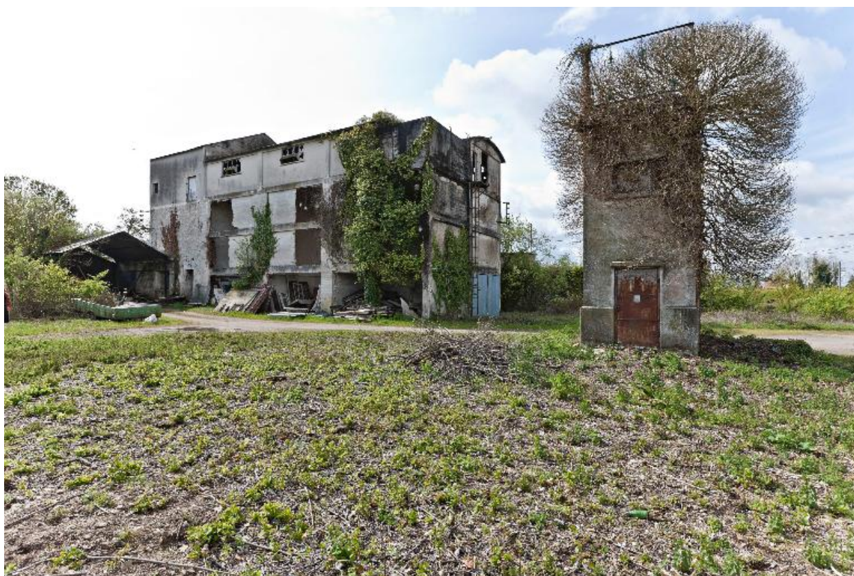
La bluterie et le transformateur électrique vus depuis le nord.
