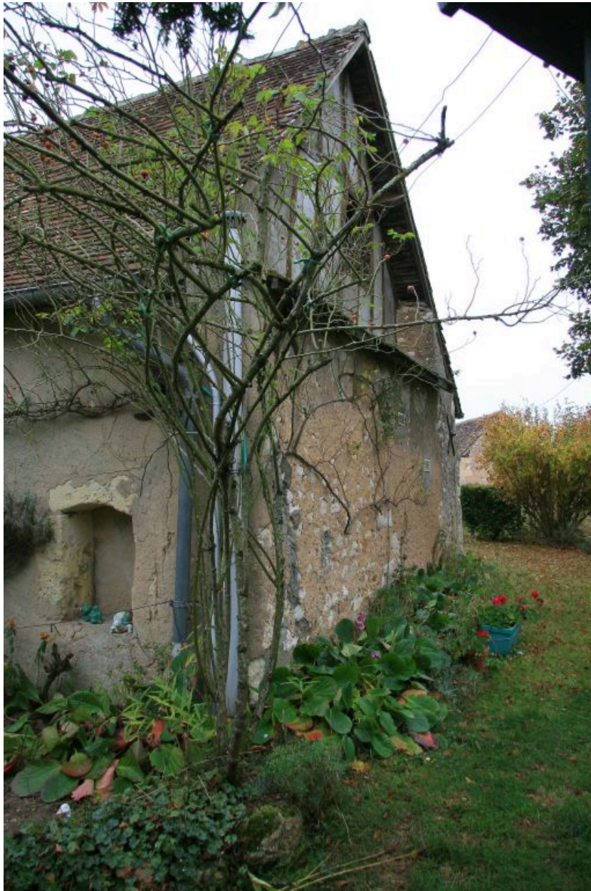
La Fleurtière, écart : pignon en bois (mur de refend ?).
