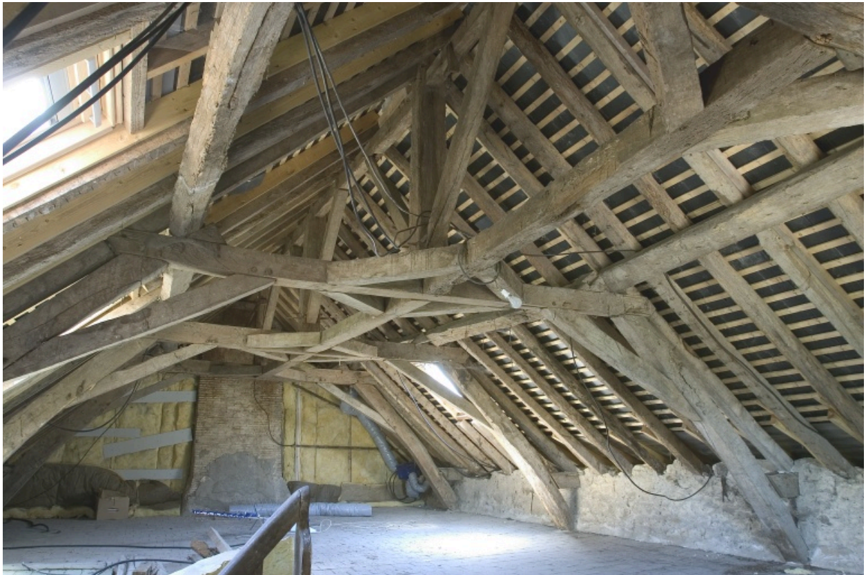
Deuxième ferme, logis : la charpente vue depuis le nord.
