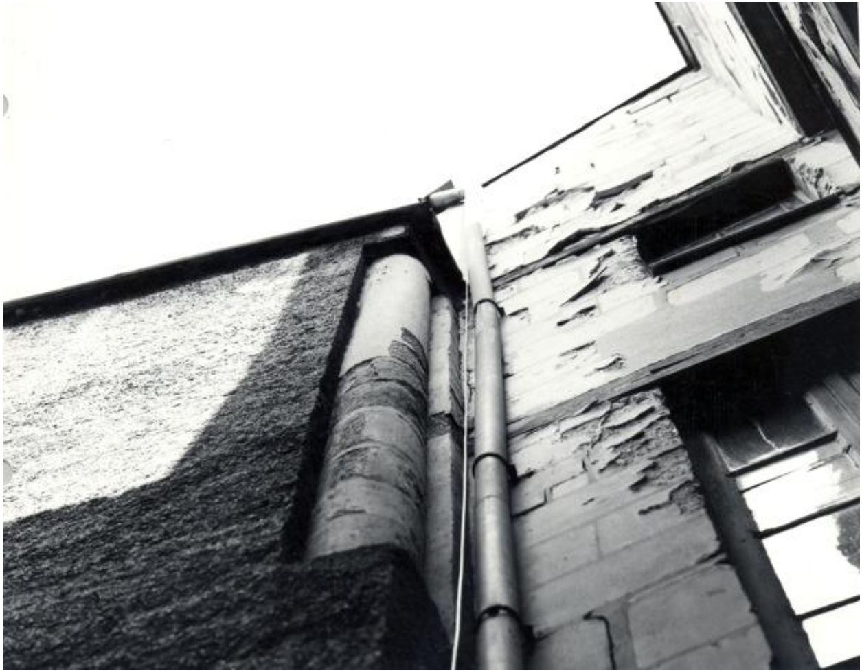
Logis principal 12e s., corps principal, élévation postérieure : colonne d'angle sud-est.
