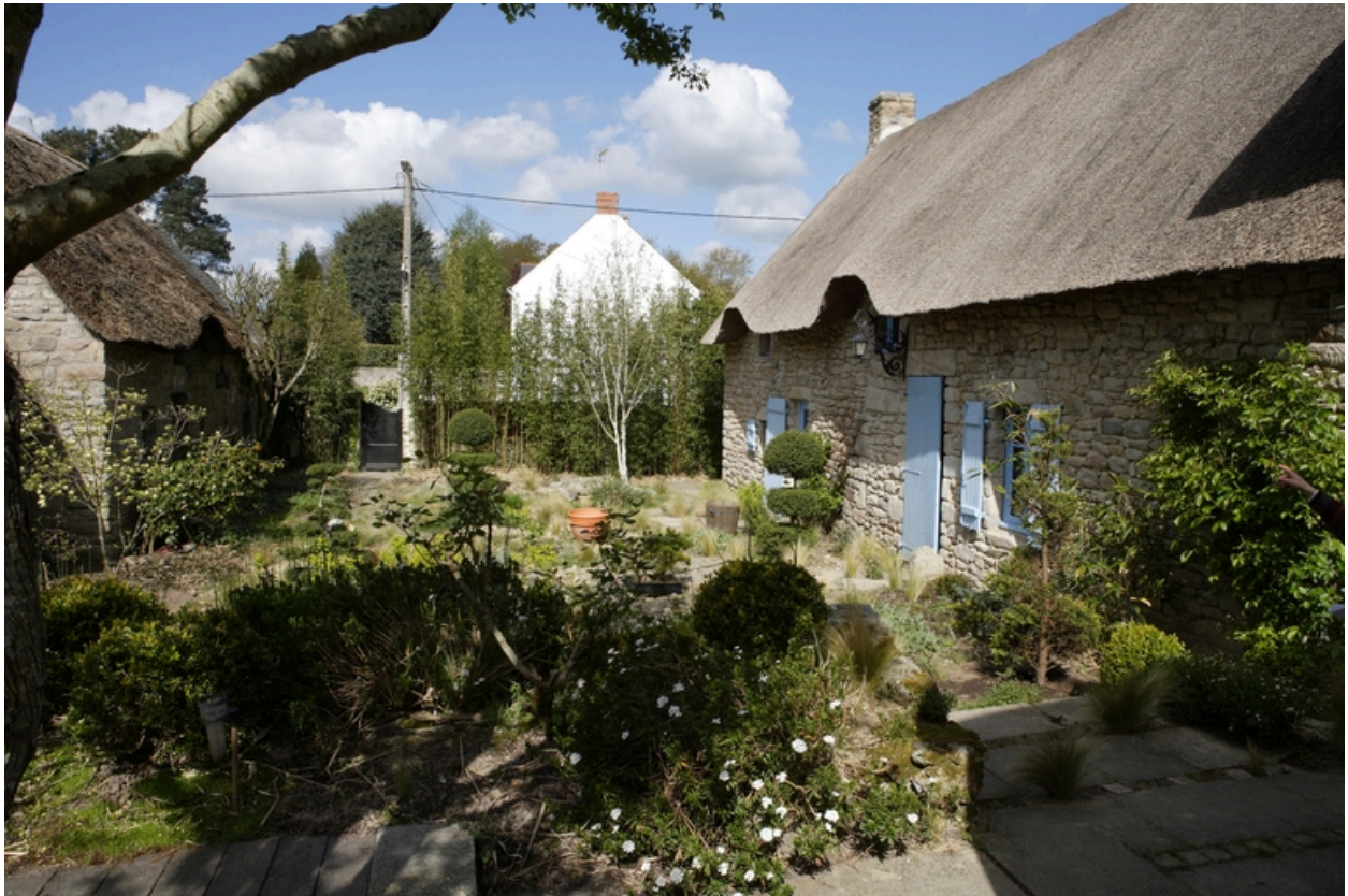
Vue d'ensemble depuis l'ouest.
