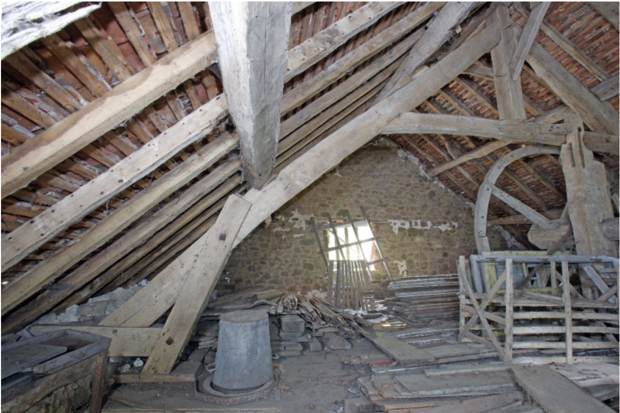
Le moulin à farine sur la Mayenne : le comble vu depuis le nord.
