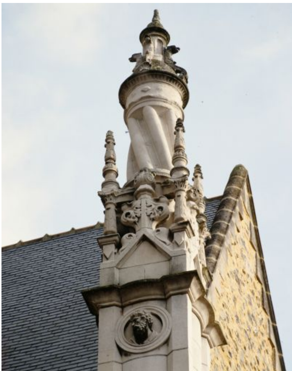
Elévation antérieure, contrefort : vue d'ensemble.
