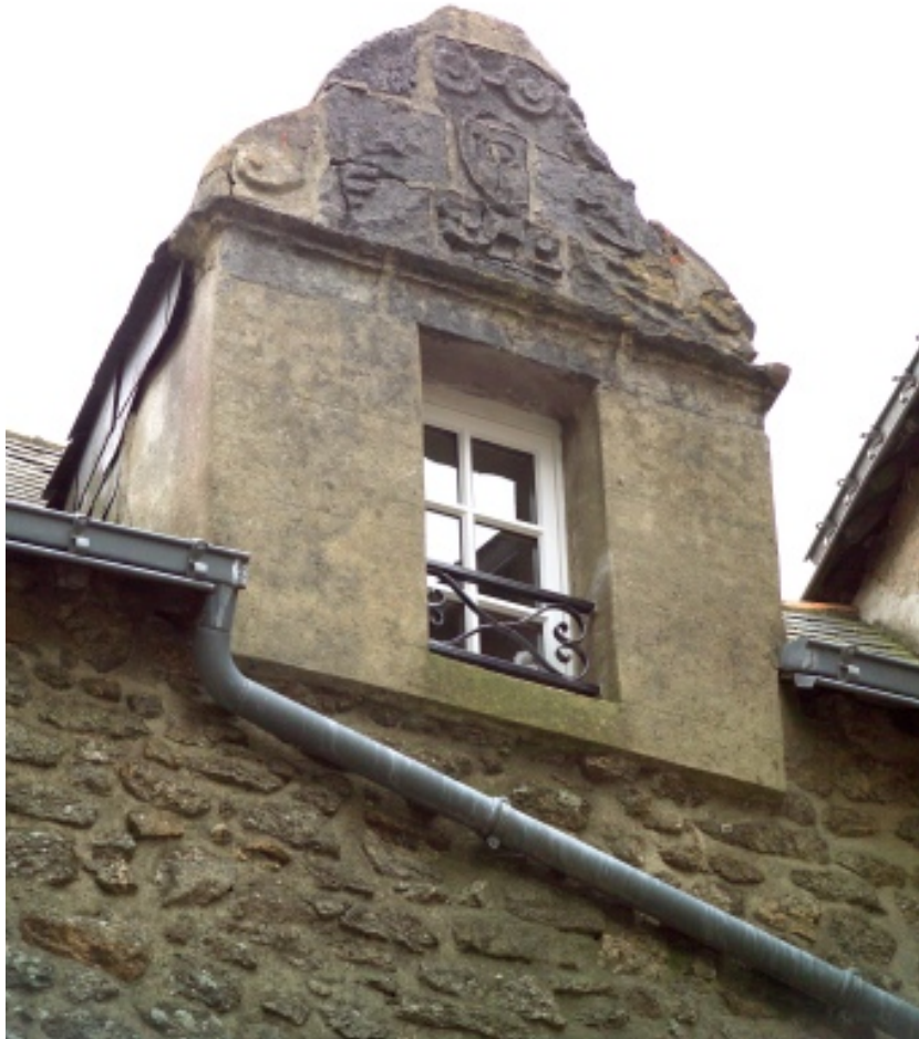
Partie arrière dans la rue du Saint-Esprit, détail de la lucarne.
