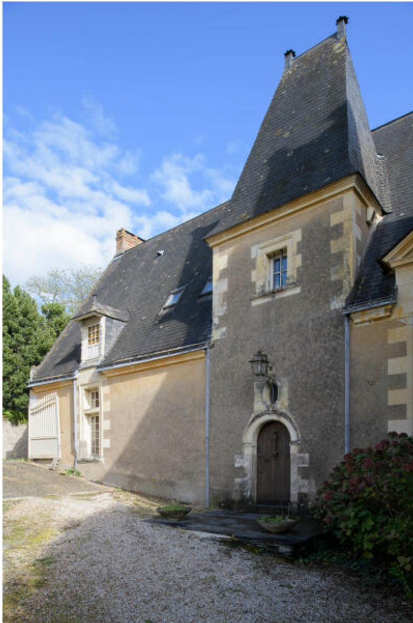
Détail de la travée centrale.
