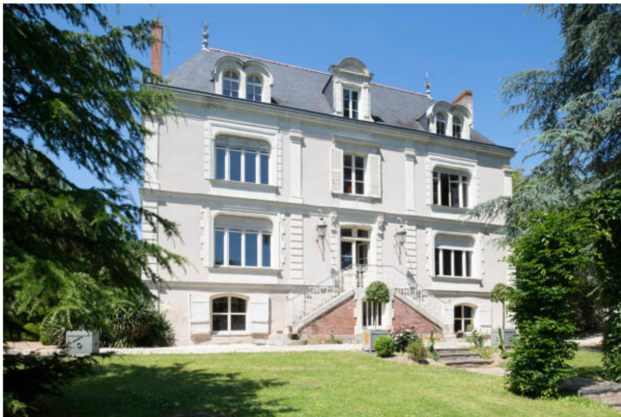
Vue de la façade est.
