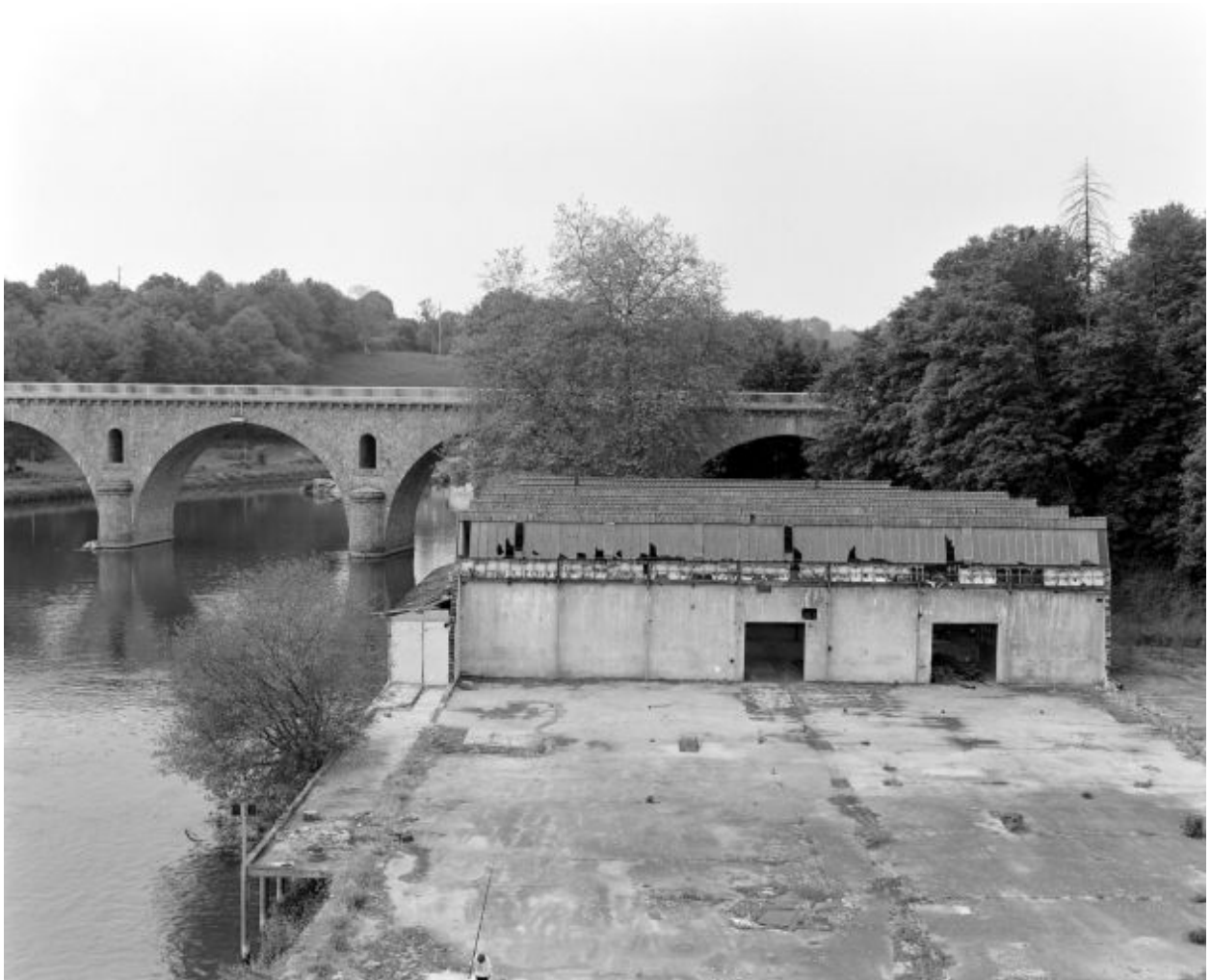
Bâtiments à couverture en sheds subsistant. A l'arrière-plan, le pont de Rochefort.
