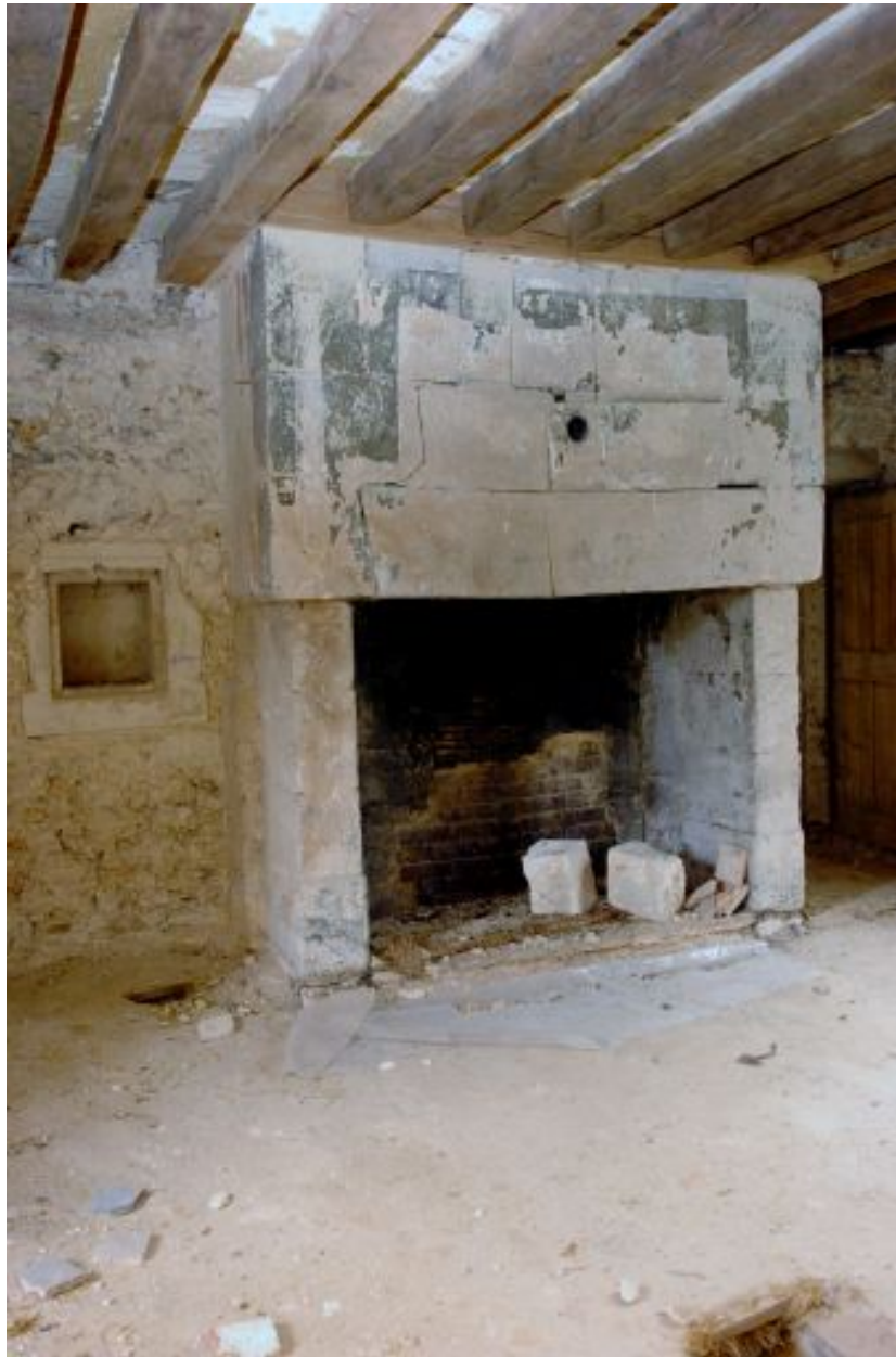
1er étage salle de gauche : cheminée et placard.
