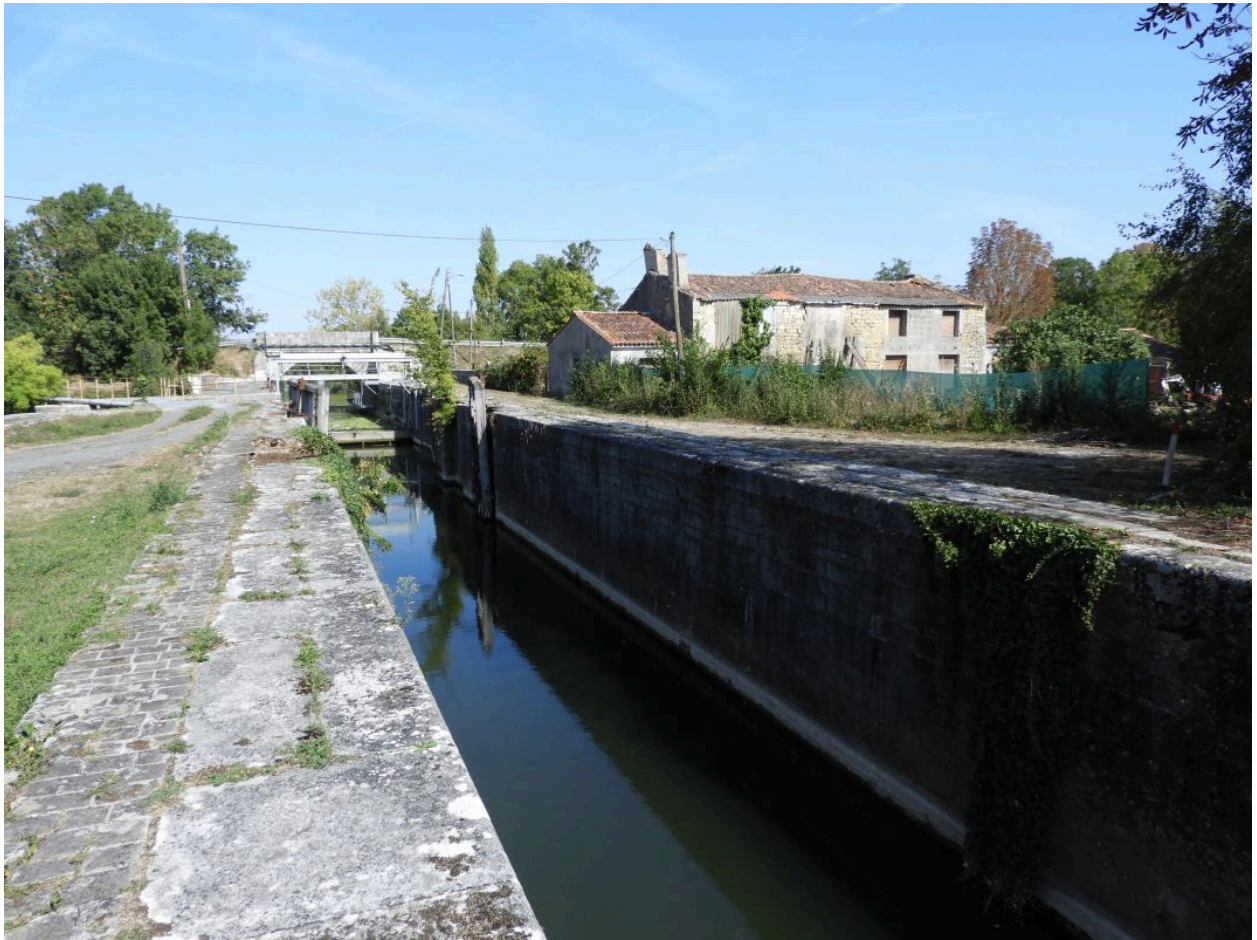
Le sas de l'écluse vu depuis la rive droite, au sud-ouest, avec la maison de garde de l'aqueduc à l'arrière-plan.
