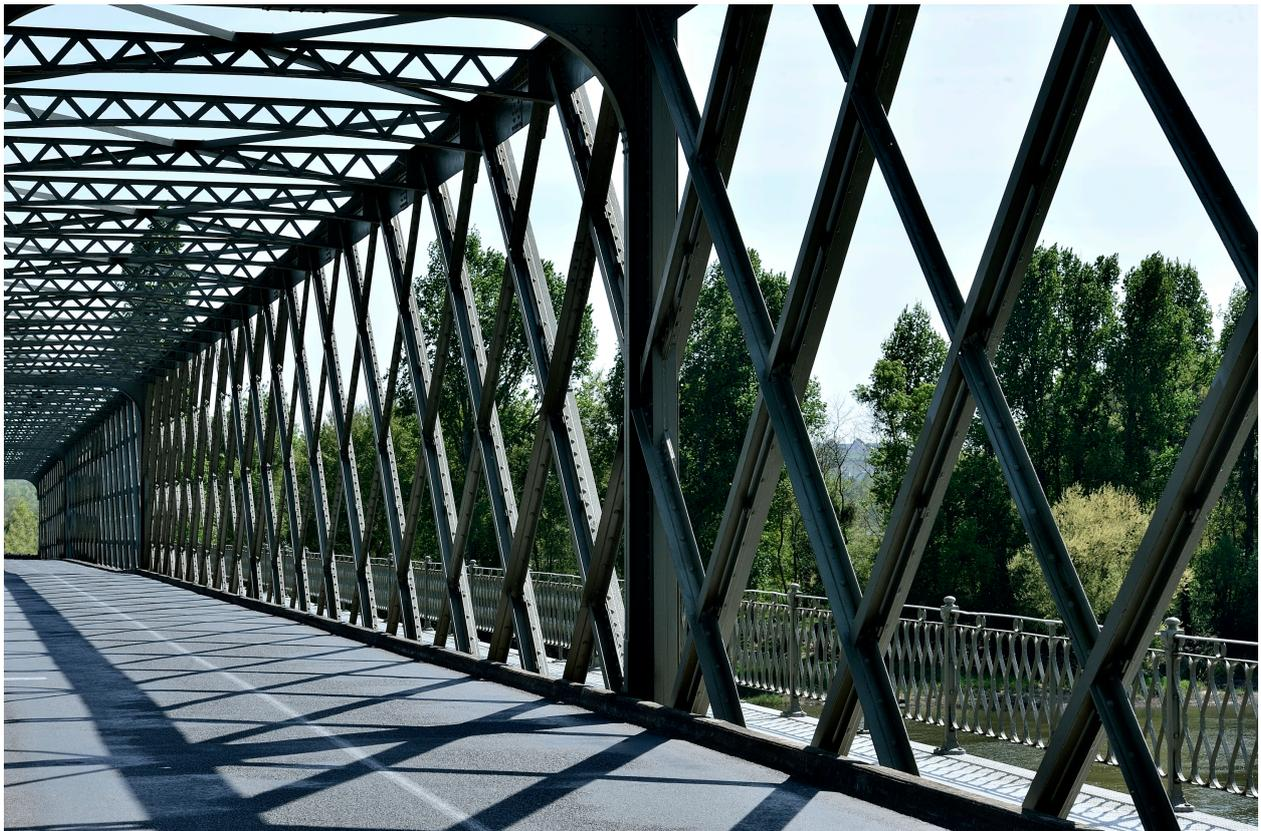
Vue du pont cage en treillis, en fer forgé.
