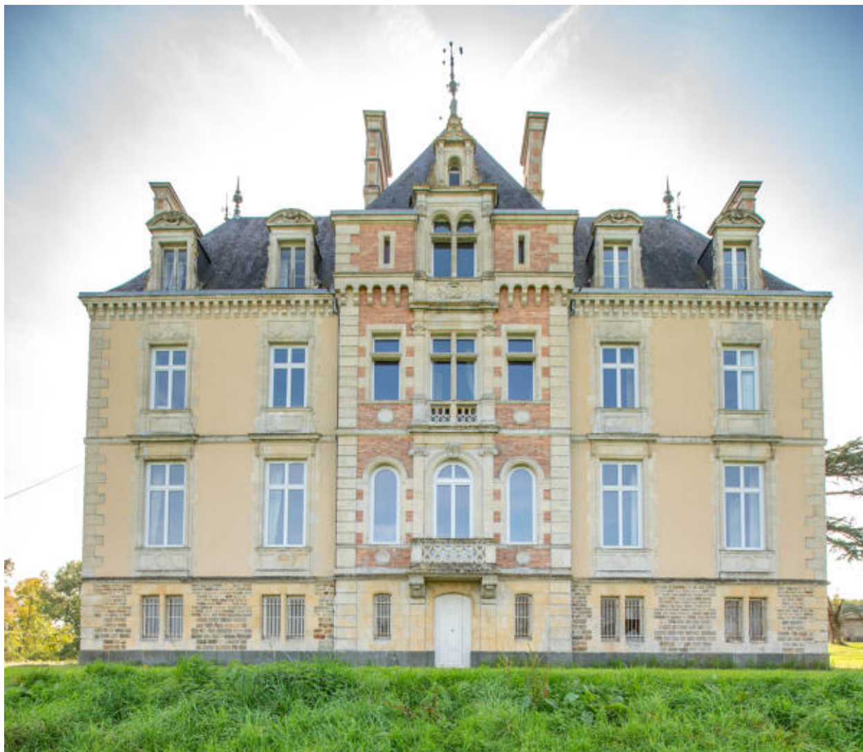
L'élévation postérieure du château.
