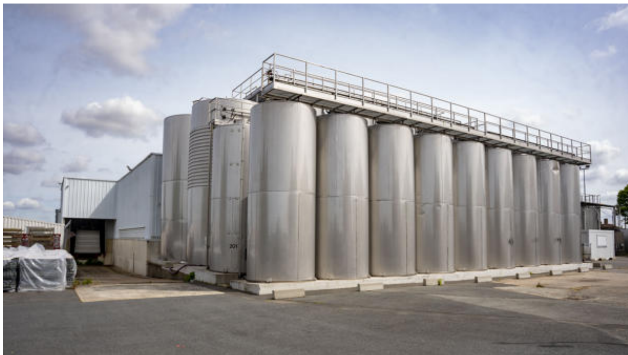
Cuverie, au sud du site.
