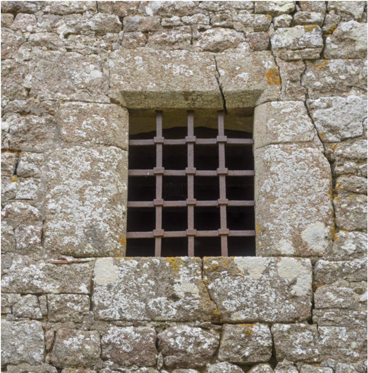
Une baie chanfreinée à grille de la façade postérieure du logis.
