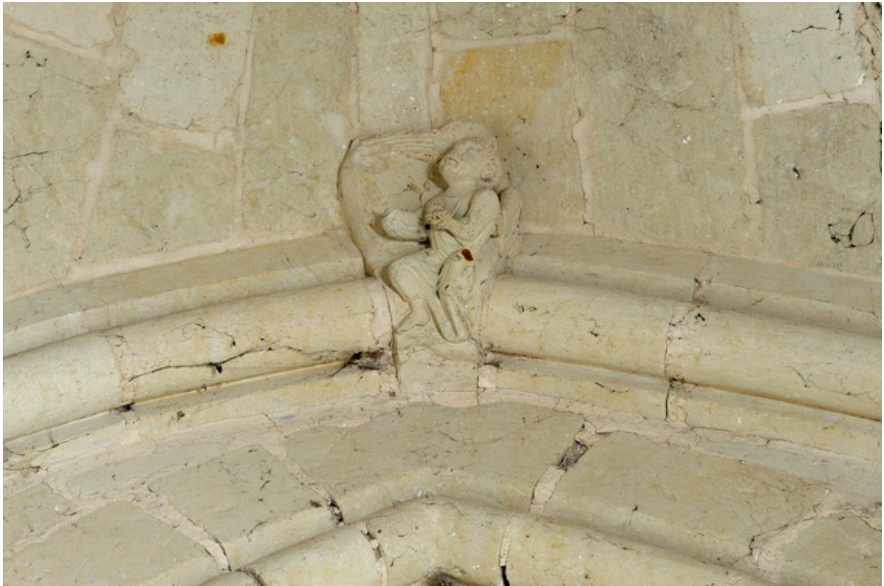
Chapelle orientée du bras sud du transept, clef du formeret est : ange thuriféraire (?).
