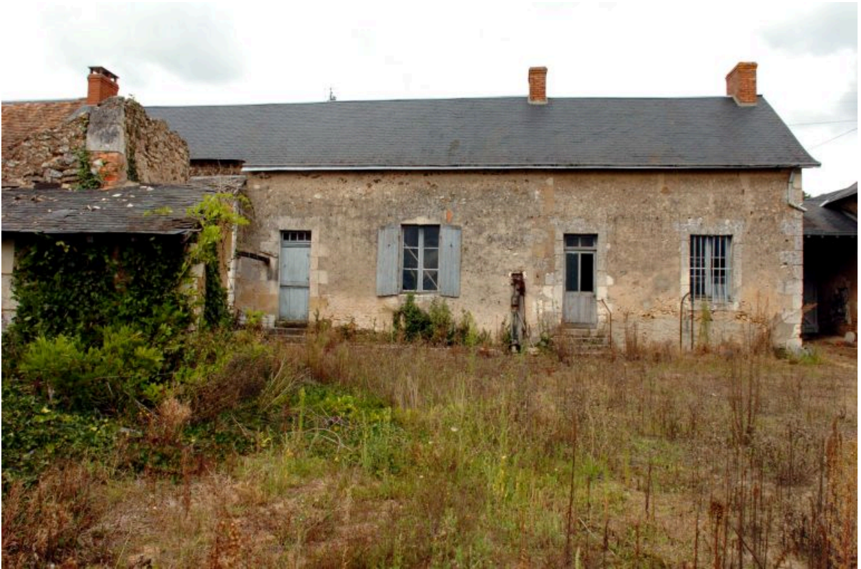
Façade antérieure sur cour.
