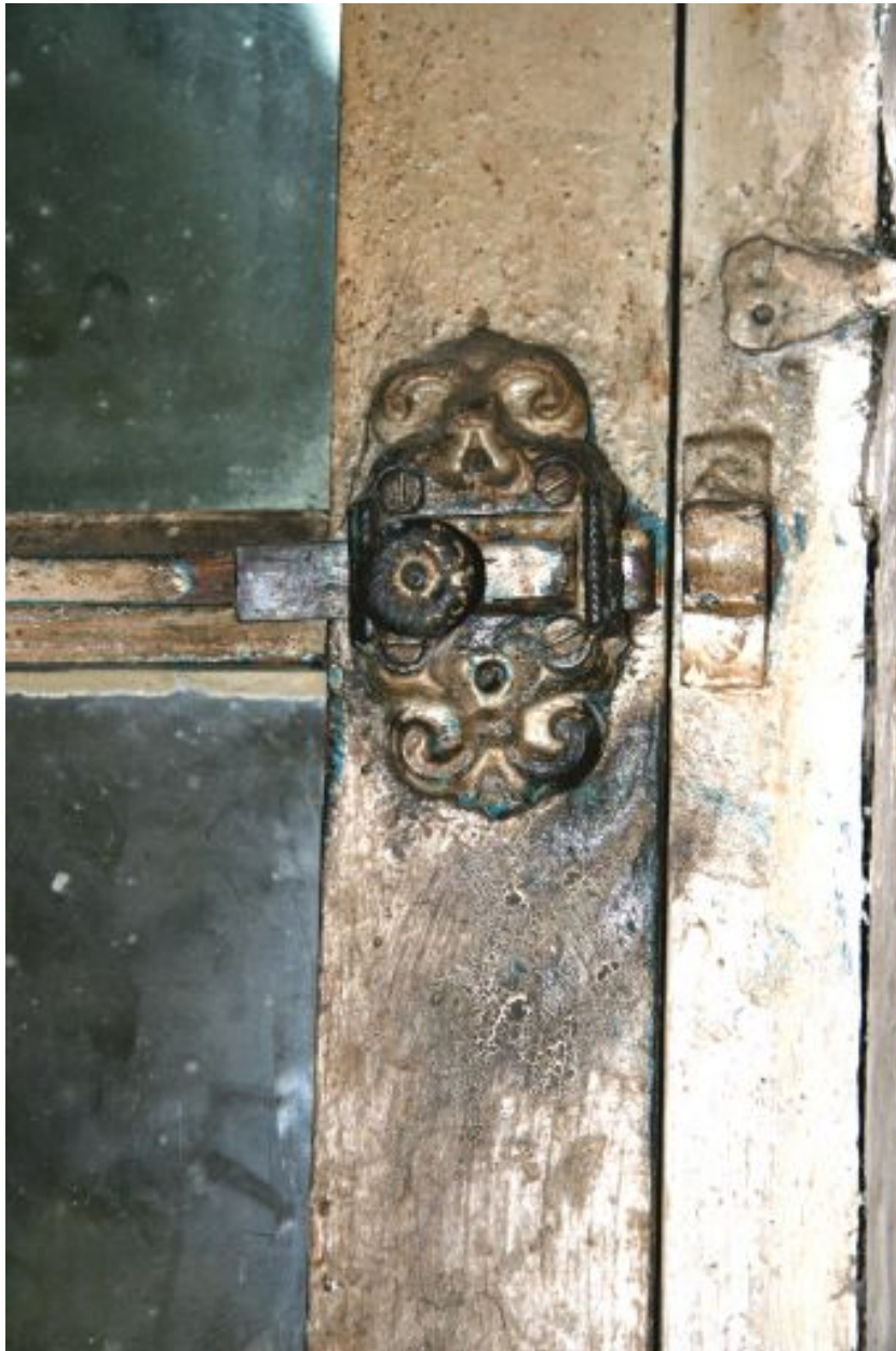
Maison au fond de la cour : targette de la fenêtre.
